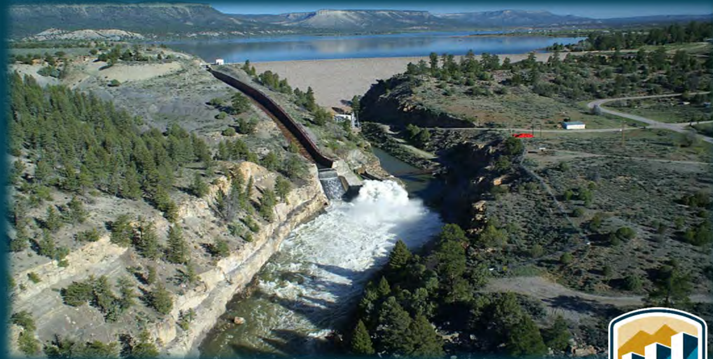
El Vado Dam, NM
