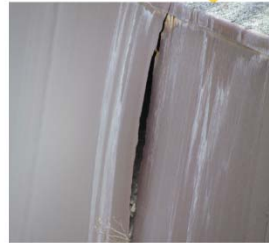
El Vado Dam
